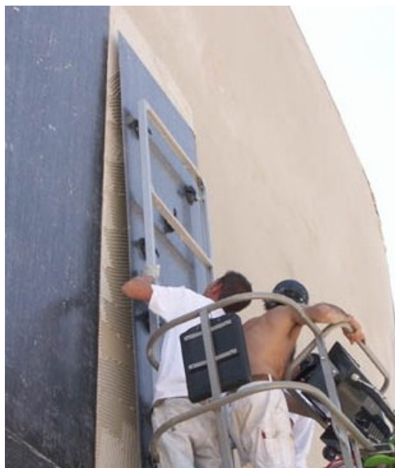
Posa in facciata
