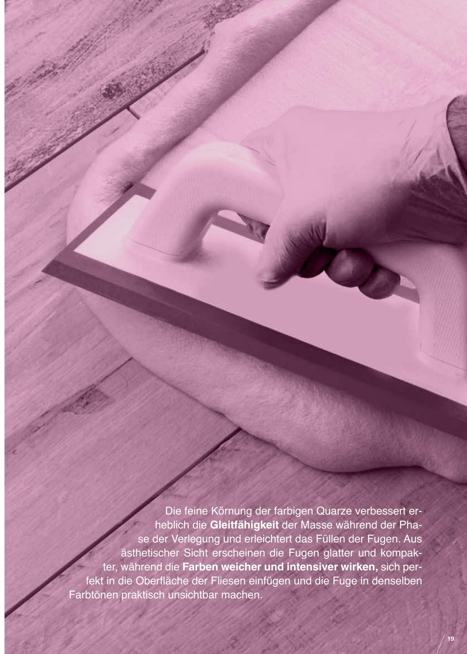
Die feine Körnung der farbigen Quarze verbessert erheblich die **Gleitfähigkeit** der Masse während der Phase der Verlegung und erleichtert das Füllen der Fugen. Aus ästhetischer Sicht erscheinen die Fugen glatter und kompakter, während die **Farben weicher und intensiver wirken**, sich perfekt in die Oberfläche der Fliesen einfügen und die Fuge in denselben Farbtönen praktisch unsichtbar machen.
